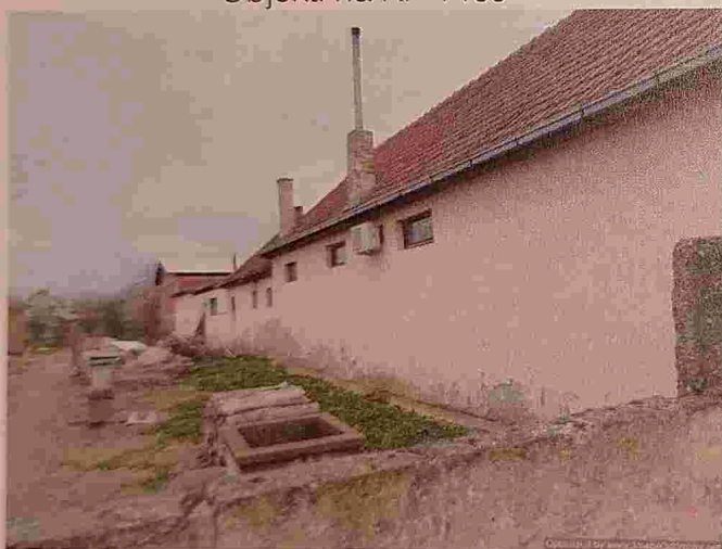
Objekti na KP 1469
