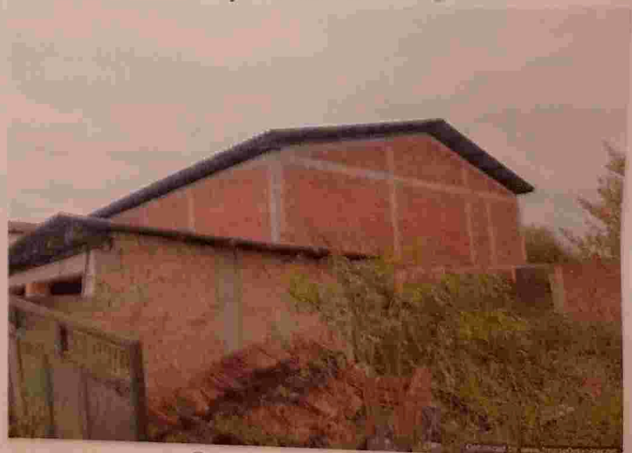
Objekti na KP 1470
