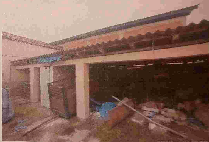
Objekti na KP 1470
