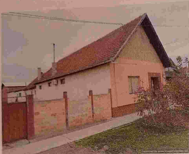
Objekti na KP 1469
